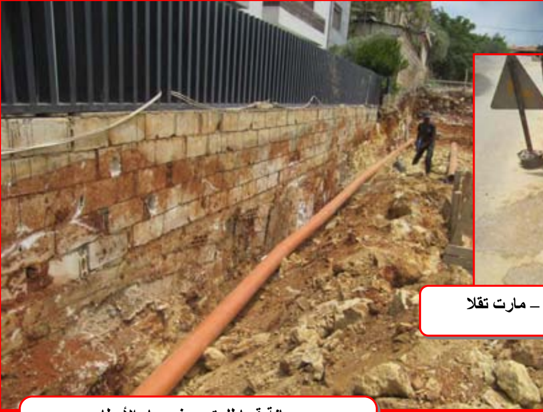
صيانة قساطل تصريف مياه الأمطار في الصورة : خلف شركة بيبسي كولا
