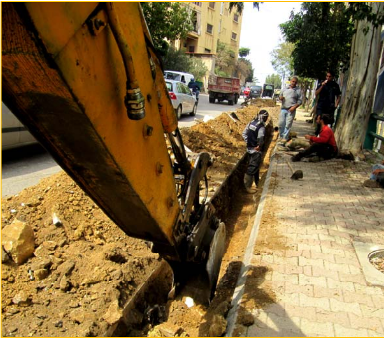
صيانة وتبديل: قساطل لتصريف مياه الأمطار، وتمديد قساطل جديدة مع ردم الحفرة والتزفيت واعادة الوضع الى ما كان عليه سابقاً
