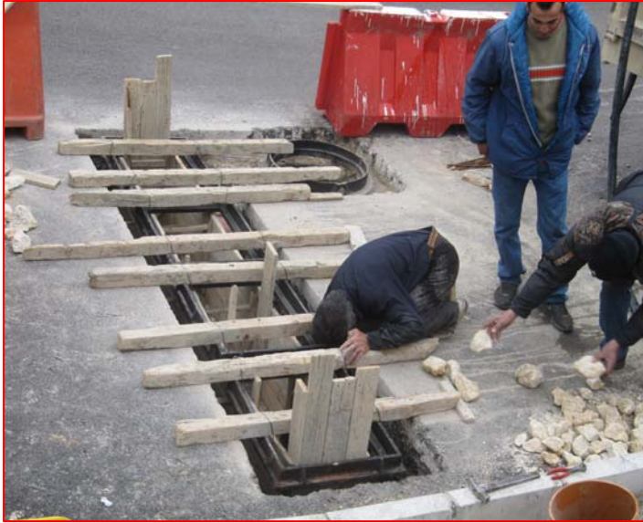
قطاعات: حفر وانشاء قطاعة لتصريف مياه الأمطار - جنب محطة جبور
