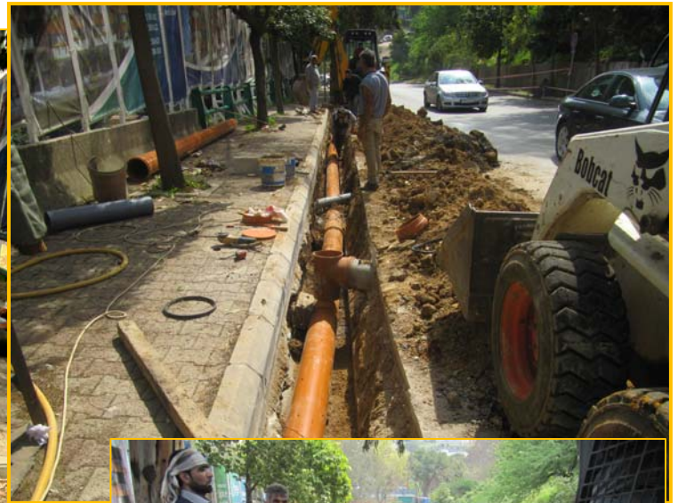
قطاعات: حفر وانشاء قطاعة لتصريف مياه الأمطار - جنب محطة جبور
