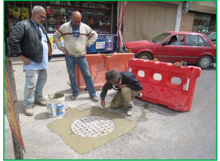
رفع الريكارات الى مستوى الزيت في الصورة: شارع مارت تقلا
